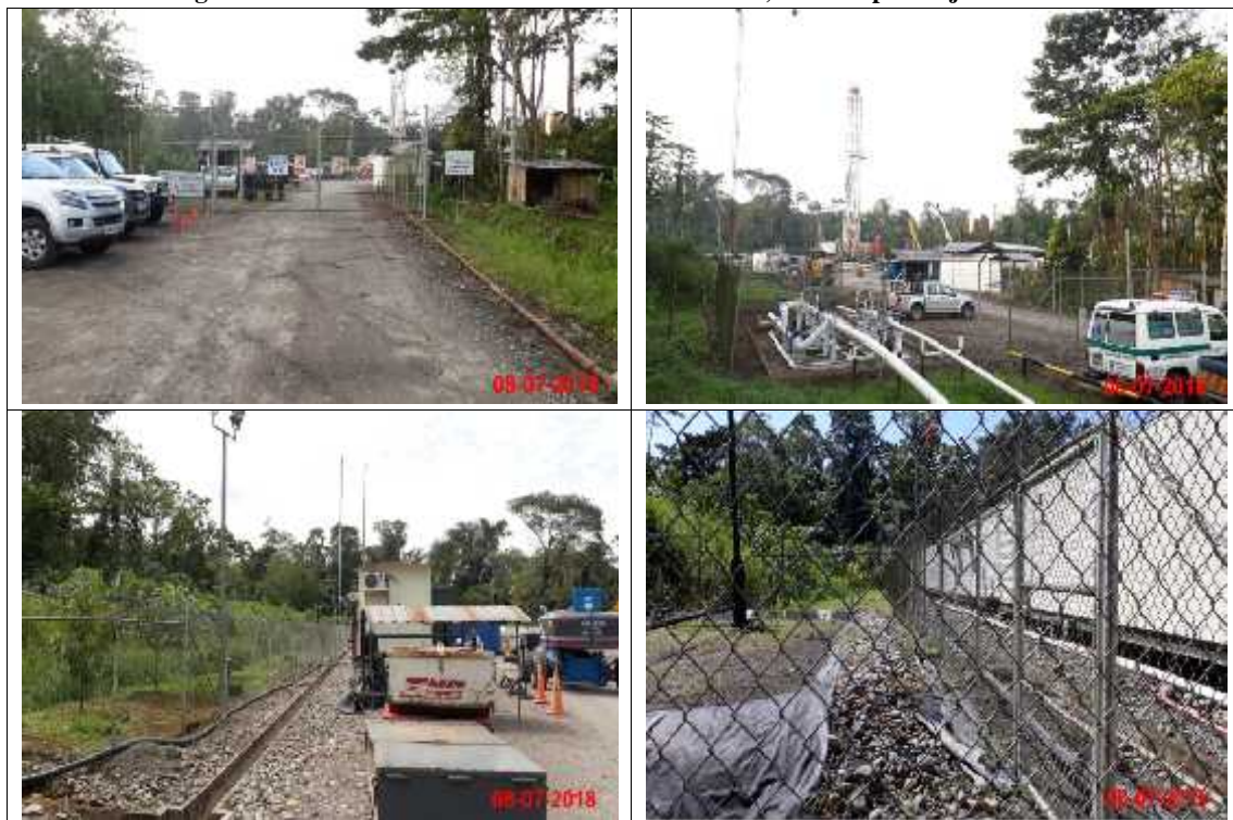
Figura 3.4. 13. Reconocimiento Plataforma INCHI A, rellenos por mejoramiento
