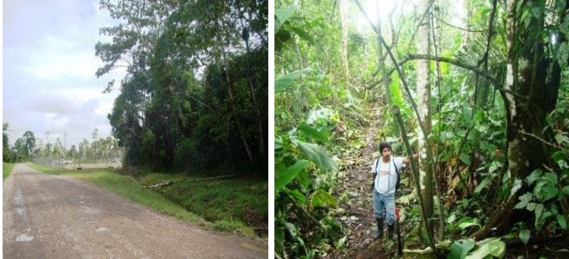
Figura 10.8. Panorámica de la Plataforma MDC 16.
