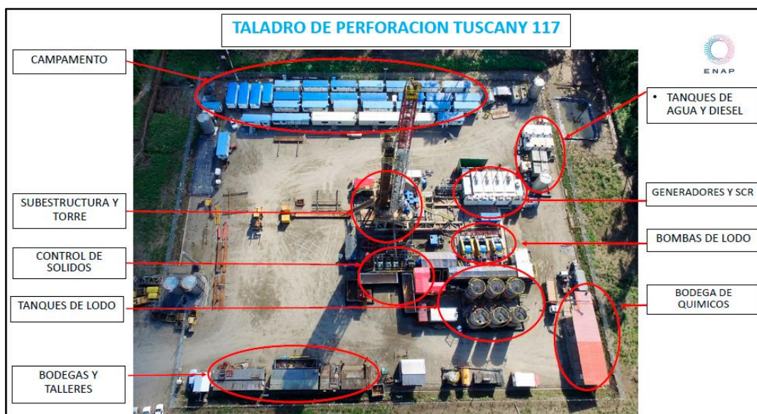
Figura 4 - 3. Plataforma Tipo de Perforación
