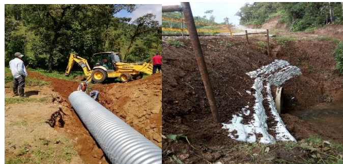
Figura 4 - 9. Ejemplo de Construcción de Alcantarillas.
